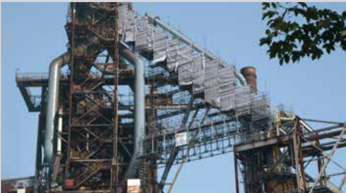
Construction „volant” pour soutenir la construction d'échafaudages-industrie.
