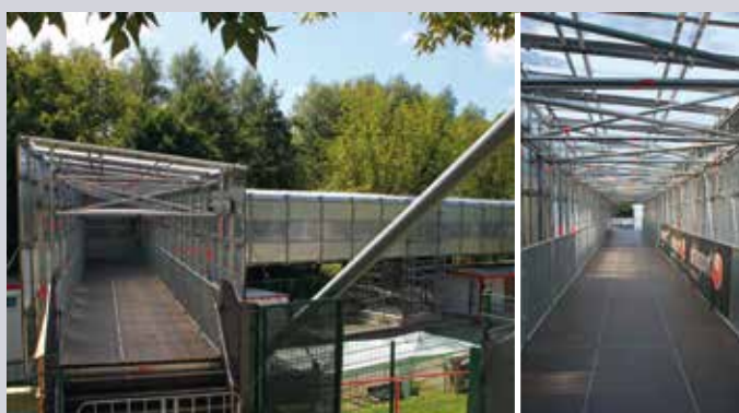
Combiné avec le toit de la cassette légère et système de protect de Layher.
