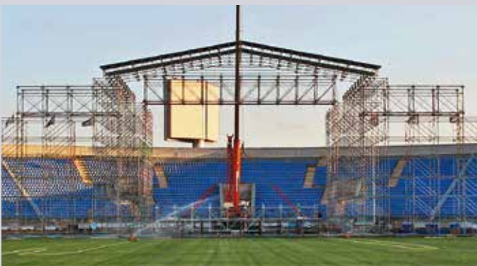
La partie structurelle du toit d'une scène de concert.
