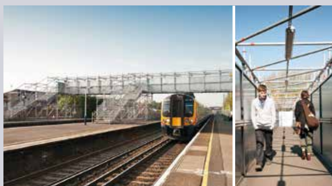
Passerelle avec système de protect à l'intérieur pour protéger les piétons.
