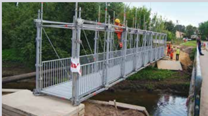
Passerelle ouverte et simple.
